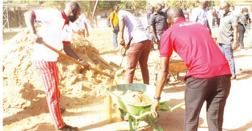
Le groupe de l'épandage à l'œuvre. Suivra la pose du pavé proprement dite
