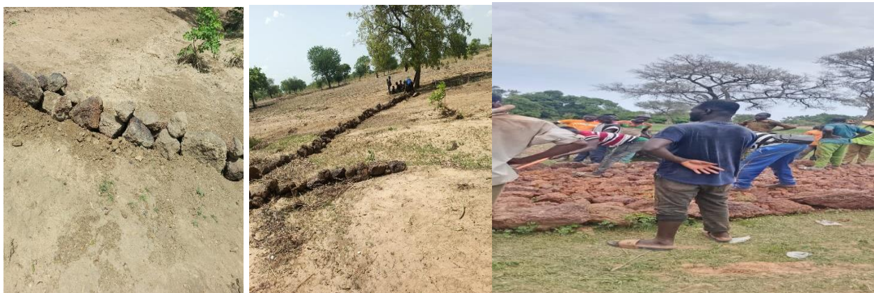
Figure 3 des cordons pierreux posés dans le champ d'un bénéficiaire Figure 4 empierrage de la route N2 entre Dakoura et Dabouedjir
