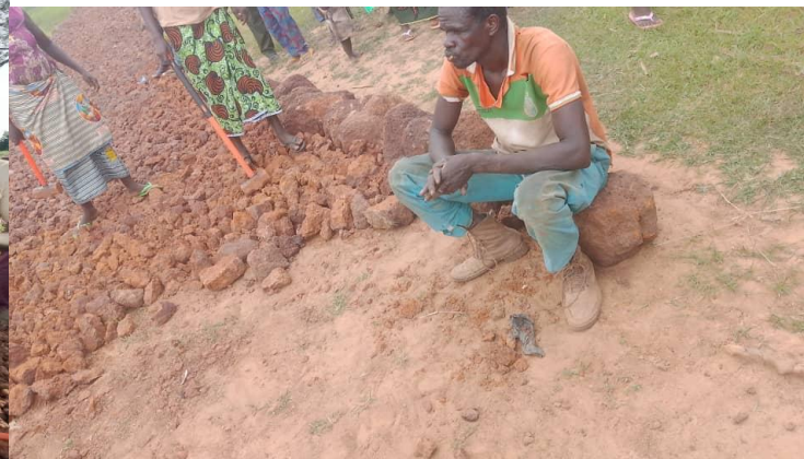
Figure 8 suite réparation de la route Dakoura-Dabouedjir
