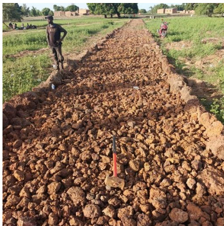
Figure 7 empierrage de la route Dakoura -Dabouedjir suite
