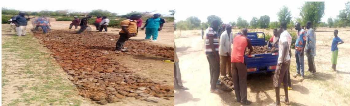
Figure 11 réparation de la route N2 Godo-pella
